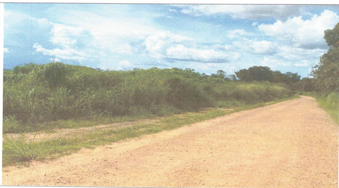
Foto – 04: Via de acesso que liga ao perímetro urbano Brasilândia - TO, março de 2026.
